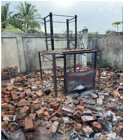
Destruction de l'ancien incinérateur...
